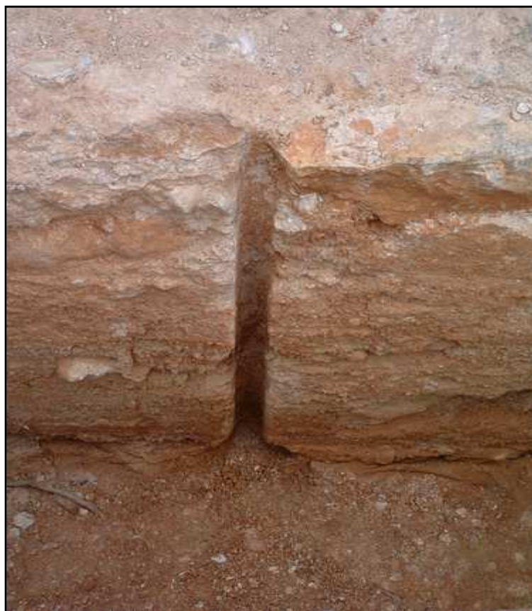
Fig.6. Detalle de la muralla con la huella de uno de los costales del encofrado.
